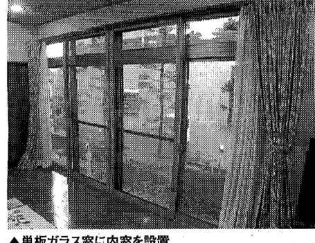
▲単板ガラス窓に内窓を設置
